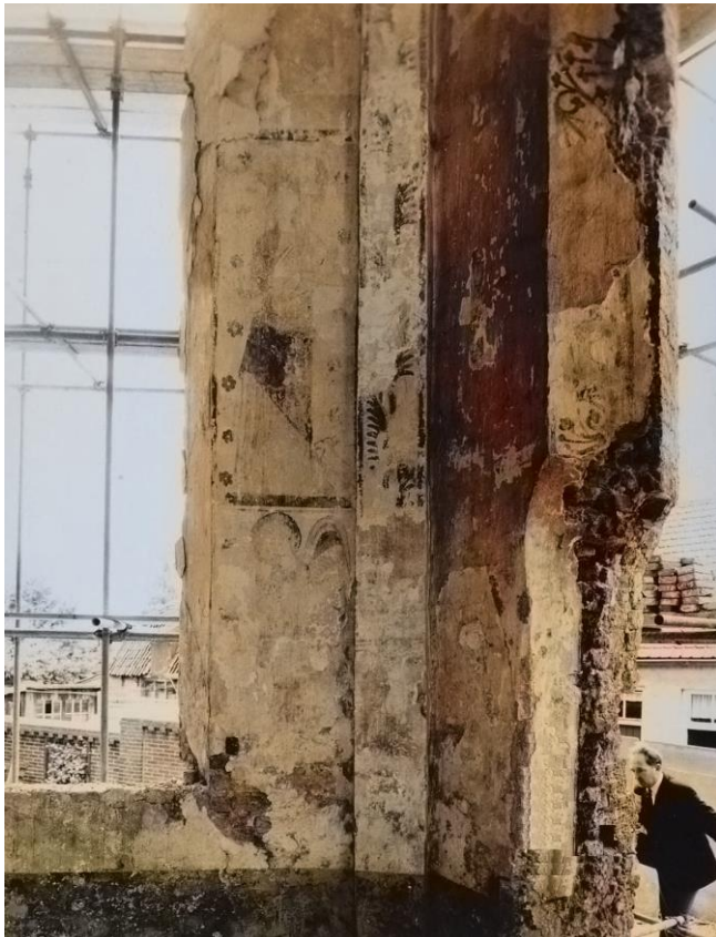
Afb. 3. Muurdam tussen het noordelijke en middelste venster.
